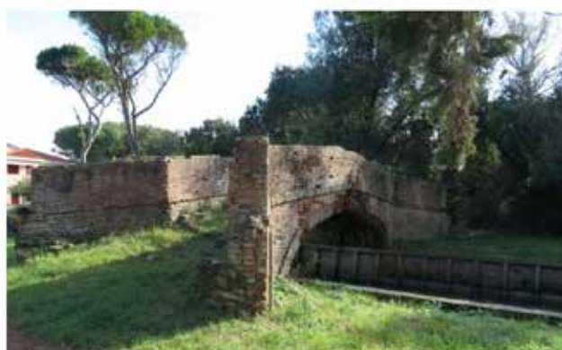
Ponte di Capocavallo sul vecchio torrente Tripesce.
